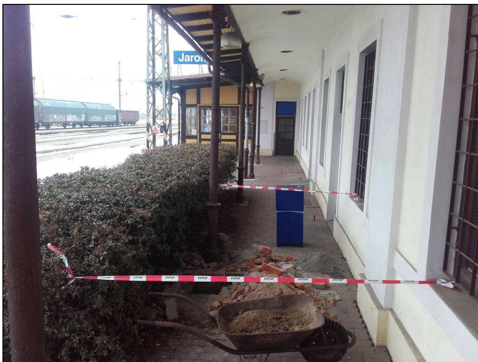
Obr. č. 6 - kopaná sonda KS1 pro ověření skrytých rozměrů základu sloupu
