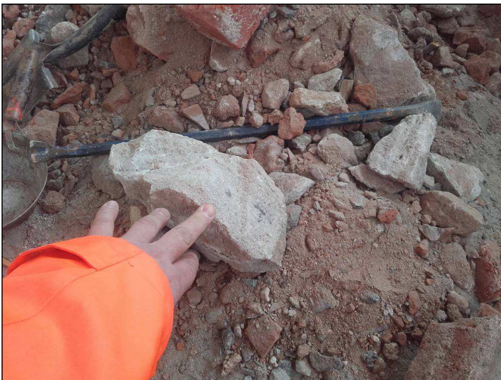
Obr. č. 10 - úlomky kamenů pískovce z kamenné rovnániny, která se nachází pod cihelnou zdí
