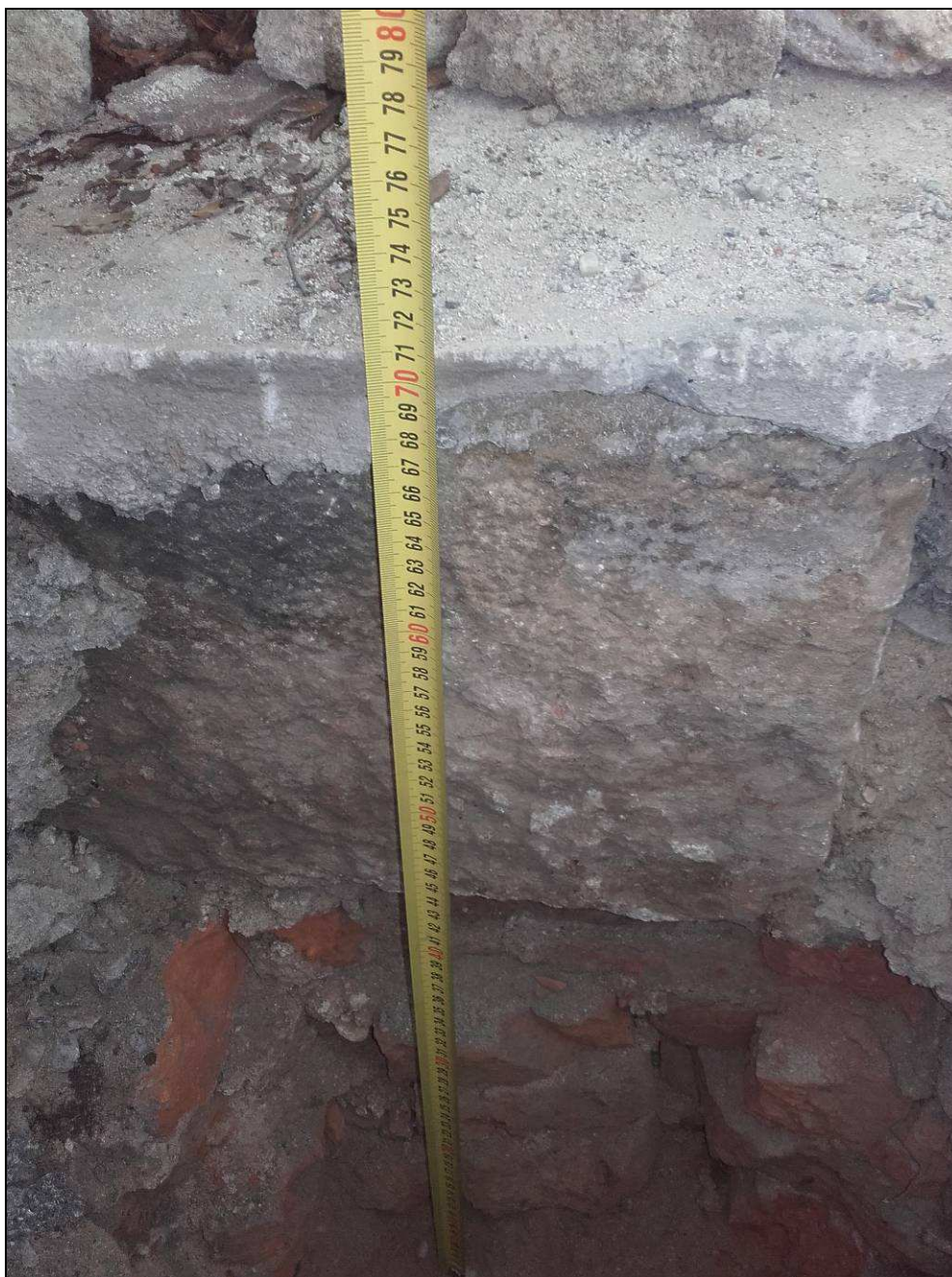
Obr. č. 7 - kamenný základ sloupu
