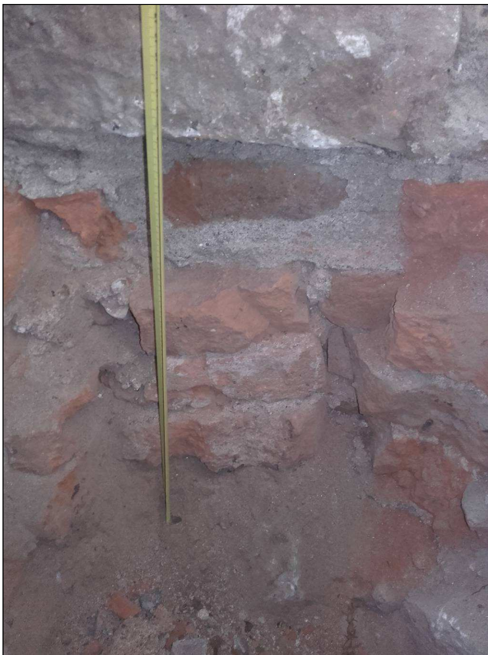
Obr. č. 8 - cihelné zdivo (pás) pod kamennou patkou
