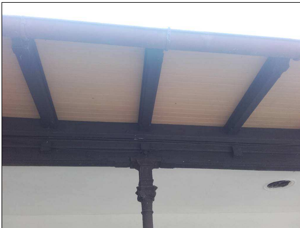
Obr. č. 3 - detail na uložení průvlaku na sloup a přesah nosníků
